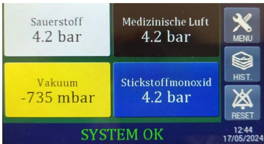
Hier werden die aktivierten Gase und ihre Drücke angezeigt. An der Seite des Bildschirms befinden sich Schaltflächen für den Zugriff auf die Einstellungen, zum Anzeigen der Historie der aufgetretenen Alarme und zum Stummschalten des Alarms.
